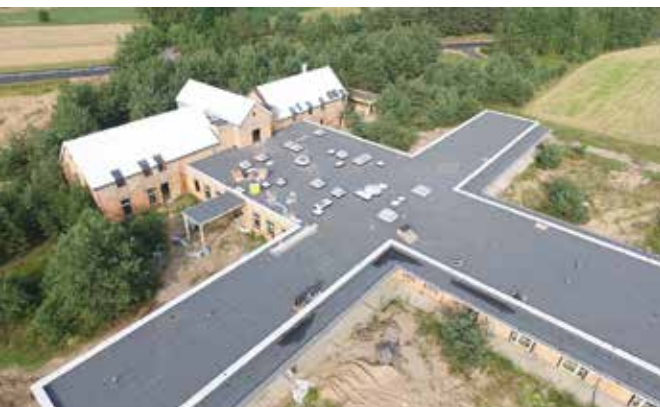
Fotografia 2.17. Hospicjum stacjonarne w budowie w gminie Michałowo
