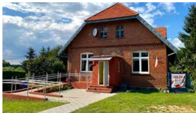
Fotografia 2.4. Budynek świetlicy wiejskiej w Mniszku
