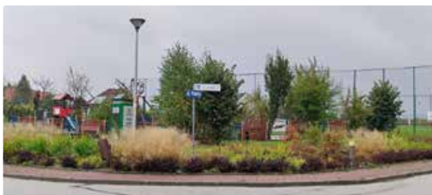
Fotografia 2.23. Widok na centrum rekreacyjne Piasecznej Górci wraz z ogrodem deszczowym
